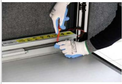
● Bloccare la GUIDA con viti autofilettanti. In alcune tipologie di pavimenti potrebbe essere necessario bloccare con viti e dadi
